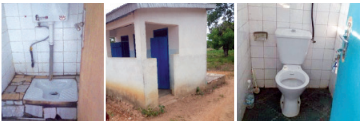
Figure 24 : Vue de quelques latrines existantes dans les EPS à l'échelle nationale
