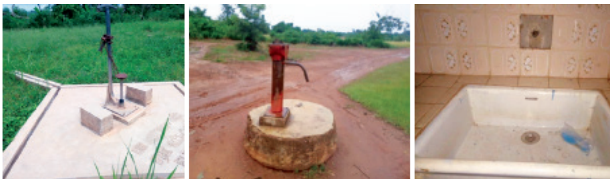
Figure 12 : Vue de trois (03) points d'eau non fonctionnels
